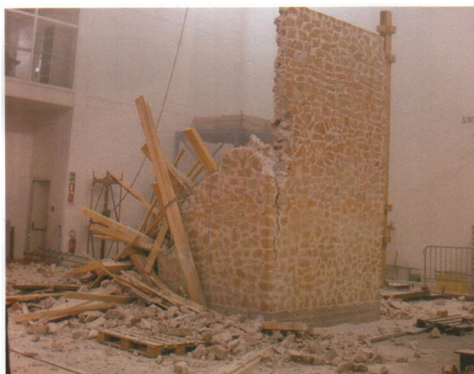
Fig. 5.5: Collasso edificio in muratura, fonte ENEA.
