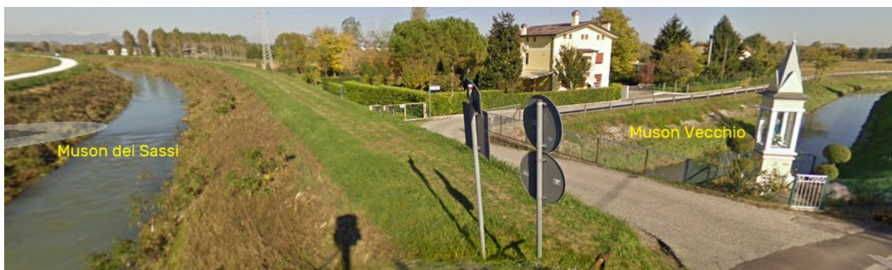
Figura 1: Incrocio tra Muson Vecchio e Muson dei Sassi tramite ponte canale, Camposampiero (fonte: Street View)
