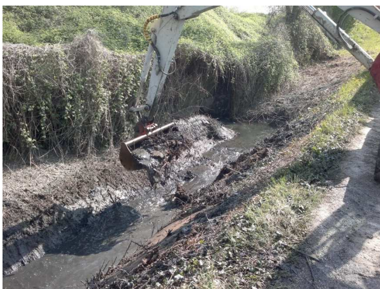
Figura 38. Spurgo di fondo della Canaletta Tentori
