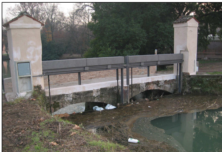
Figura 10. Paratoie presso "Mulini di Sopra" a Mirano
