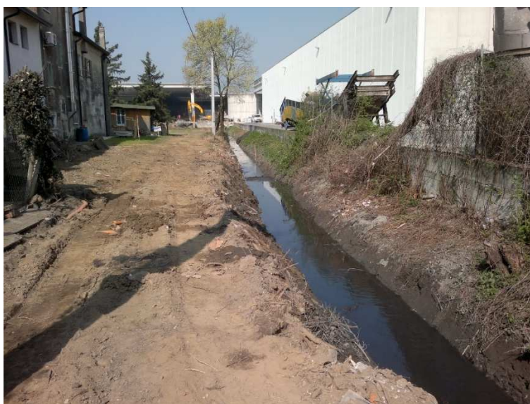
Figura 37. Ripristino transitabilità Canaletta Tentori
