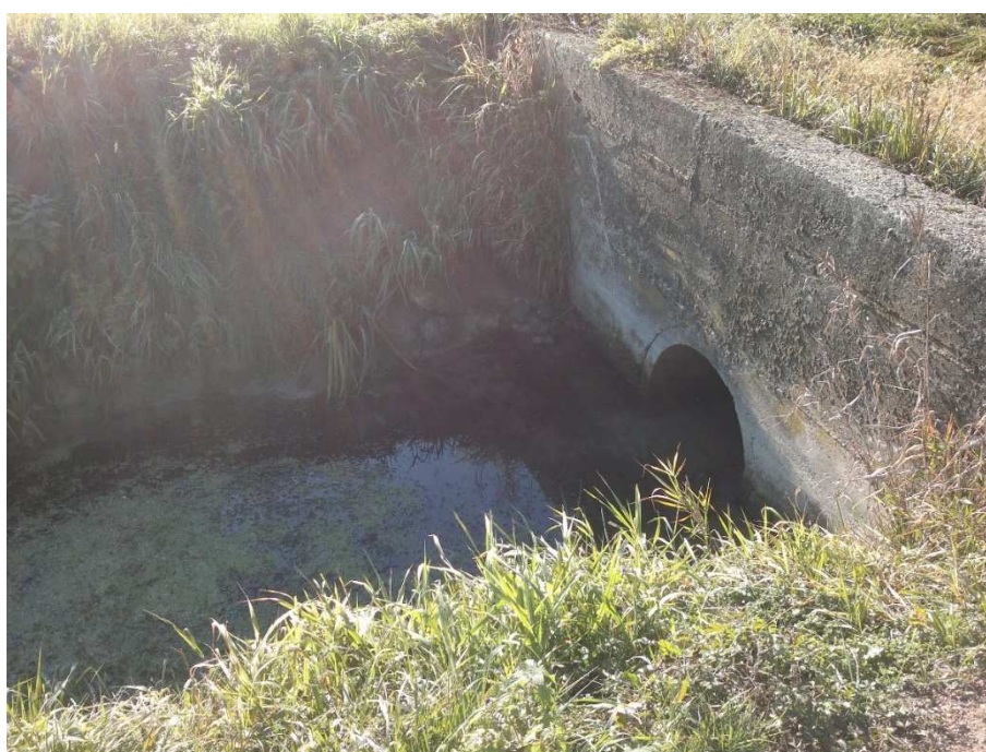
Figura 43. Ponte da rifare, int. 23
